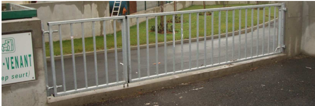
Figure 15 : Modèle de garde corps mis en place
